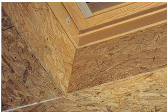
Panneaux d'OSB E1 utilisés en plafond d'un grenier et supportant un isolant en vrac.
