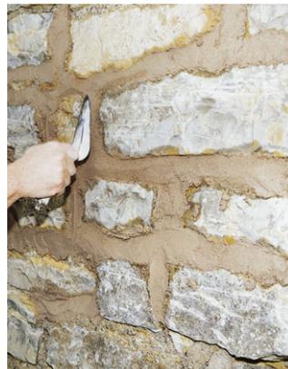
Rejointoiement de pierres calcaires à la chaux et au sable
